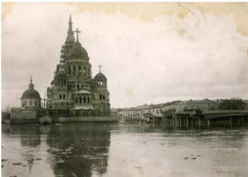
Іл. 1. Будівництво Благовіщенського собору. Фото О. Іваницького. 1893
