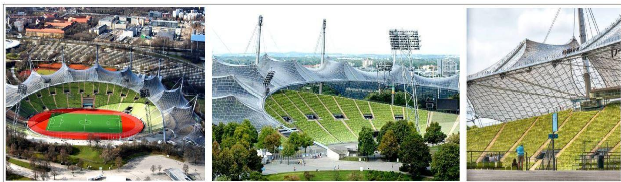
Рис.1. Біоміметичний дизайн полегшеної конструкції кабельної сітки Мюнхенського Олімпійського стадіону. Режим доступу:
