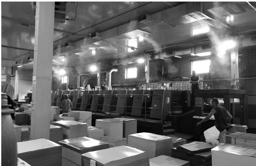
Приклад застосування туманоутворюючої системи адіабатичного типу в друкарні, м. Київ
